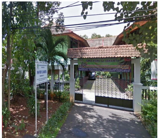
Gambar 1. Kondisi SMA PGRI 12
