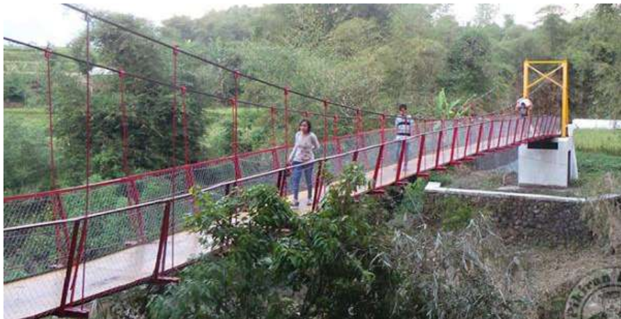
Gambar 2. Jembatan sistem kabel.
