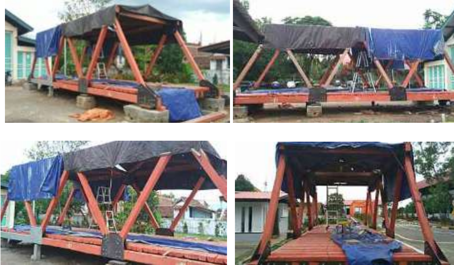
Gambar 8. Struktur jembatan selesai dirakit dan persiapan pengujian pembebanan. (Kevin, 2015; Almuhtisyah, 2015).
