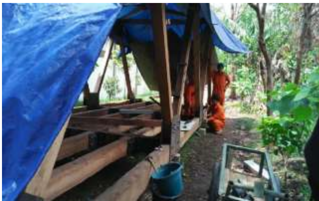
(a). Pemasangan sambungan pada join. (b). Persiapan pemasangan papan lantai jembatan.
