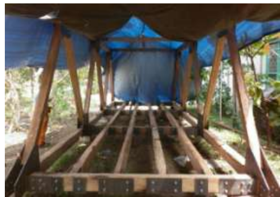
(a). Pemasangan sambungan pada join. (b). Persiapan pemasangan papan lantai jembatan.
