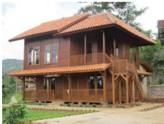
Gambar 3. Rumah modular kayu sistem knock-down .
