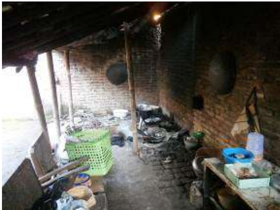
Gambar 3. Ruang produksi sebelum perbaikan
