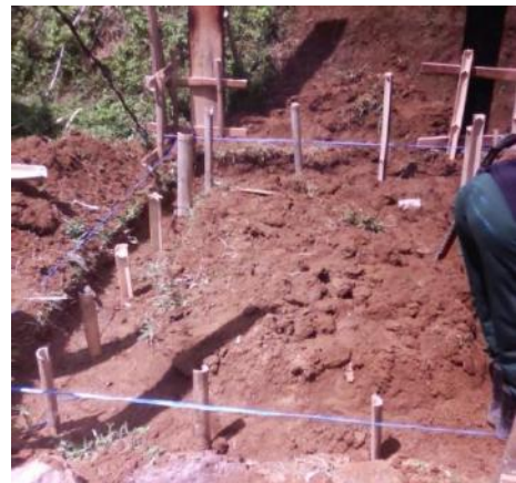
Gambar 11. Pemasangan cerucuk bambu pada pondasi
