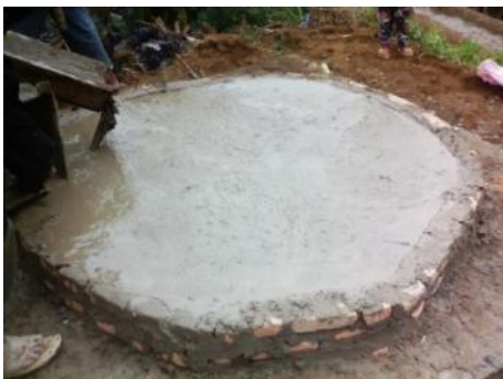
Gambar 16. Pengecoran lantai/dudukan bak
