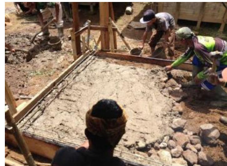
Gambar 12. Pekerjaan lantai bak penampungan utama
