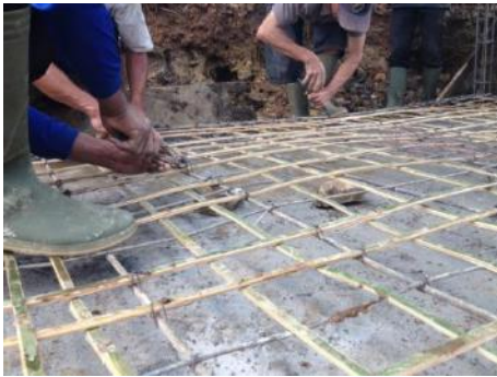
Gambar 8. Penulangan bambu dan besi
