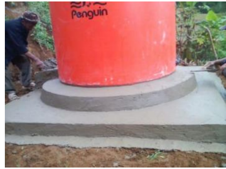
Gambar 17. Pemasangan bak torrent dan finishing lantai/dudukan
