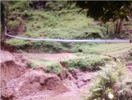
Gambar 20. Pemasangan pipa yang mengantung pada kawat seling
