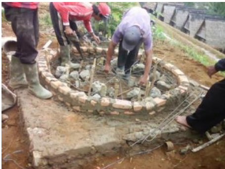
Gambar 15. Pemasangan cerucut bambu dan penulangan pada pondasi
