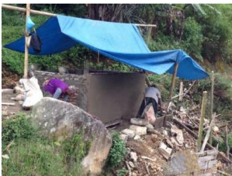
Gambar 10. Pekerjaan finishing dinding
