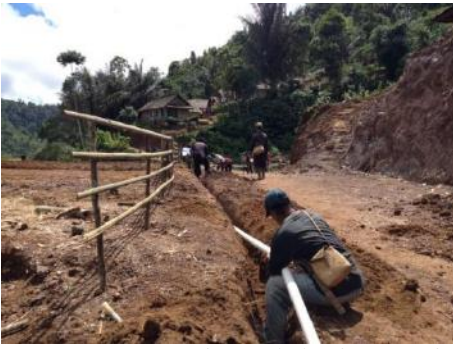
Gambar 19. Pemasangan pipa pada bagian samping badan jalan
