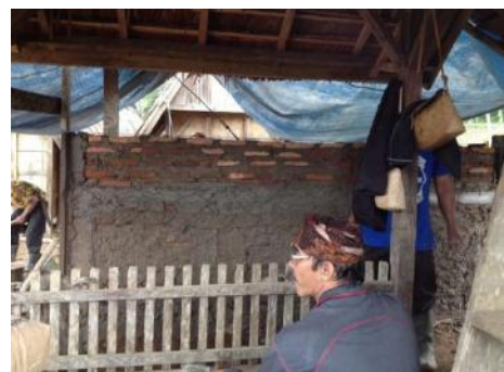
Gambar 13. Pekerjaan finishing dinding
